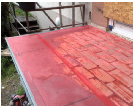
Einbau eines Armierungsgewebes
