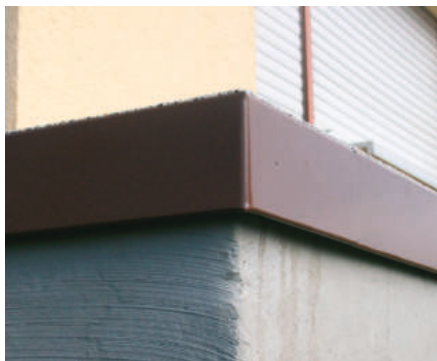
Tropfbleche werden eingebaut
