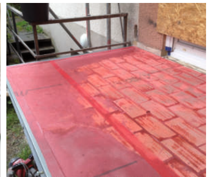
Einbau eines Armierungsgewebes
