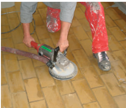
Vorarbeiten: Die Fläche wird gefräst
