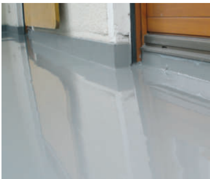
Dicht- und Nivellierschicht wird aufgebracht
